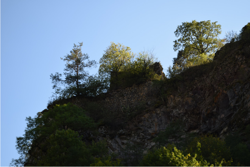
45. უზნარიანის ციხე. ხედი ჩრდილო-აღმოსავლეთიდან The fortress of Uznariani. The view from north-east.
