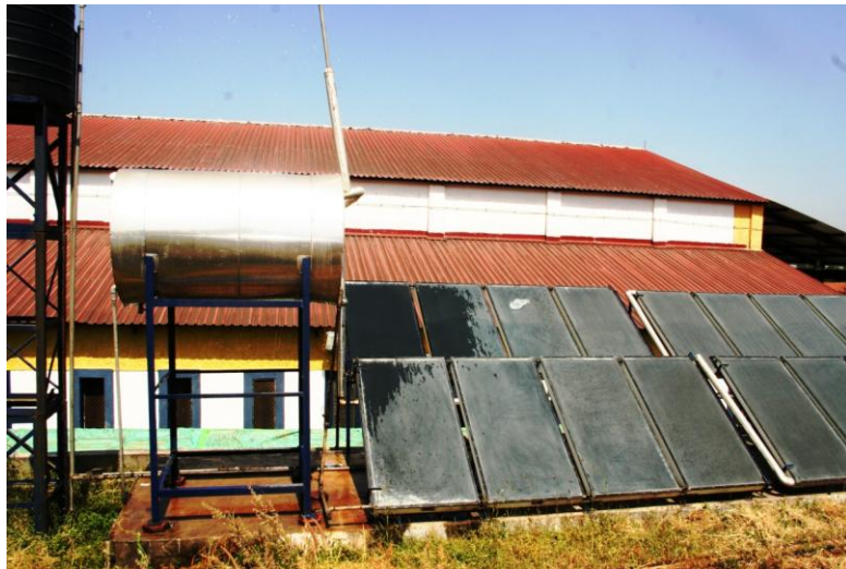
Figure 2 : Panneaux solaires de production d'eau chaude en Inde
