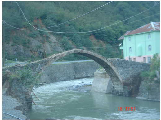
ხიდი ჩხალისწყალზე, სოფ. მამანათში, კოსტანეთის უბანში
