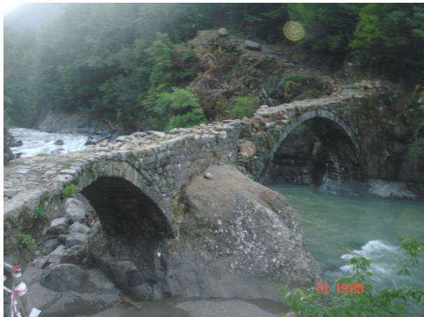
ხიდი ჩხალისწყალზე, სოფ. დუზქოში, სკიბათის უბანში
