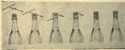
ნახ. 2. შამპანური ღვინის ბოთლის ყელზე ახალი სახის მიუზღეს ჩამოკმის ტექნოლოგიური სქემა
