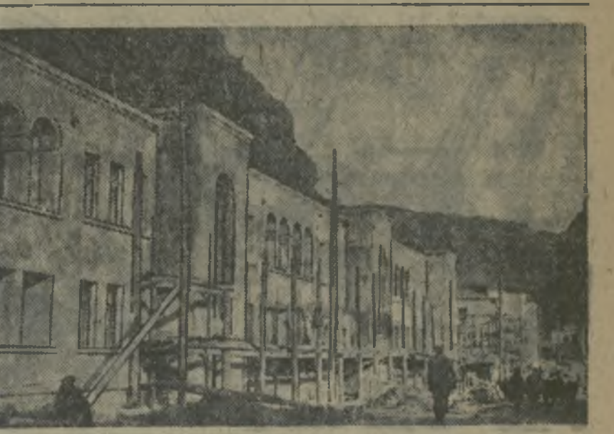
В г. Чинтура заканчивается строительство жилого дома для лучших стахановцев марганцевых рудников. На снимке: вид нового здания с фасада. (Фото Капелетова — Груза отд. Союзфотот.)
