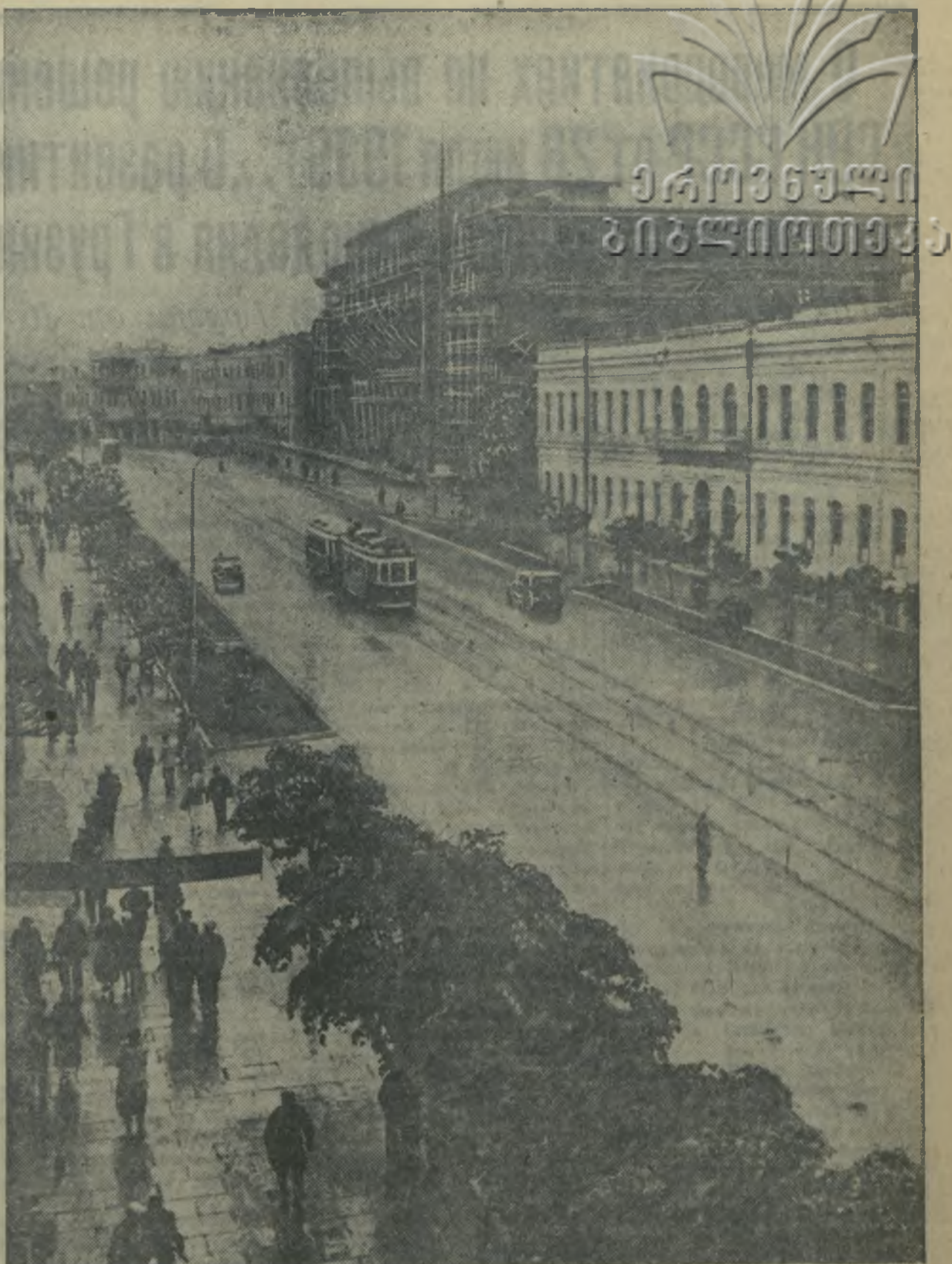
Вид на проспект Руставели. Слева — заканчивающееся строительство здания Тбилисского филиала Института Мавра — Энгельса — Ленина (Фот. Столярова).
