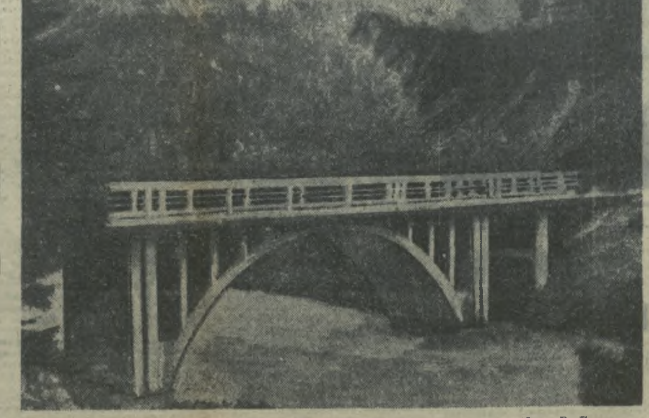
Арочный мост через реку Лиану на курорте Дауу у сел. Хиди (Юго-Осетия).
