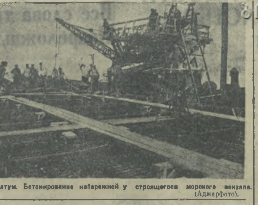
Батум. Бетонирование набережной у строящегося морского вокзала. (Аджарфот).
