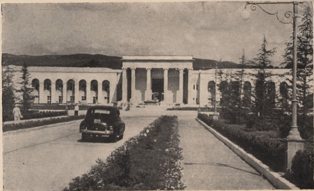
Цхалтубო. Ванное здание № 6, Общий вид.
