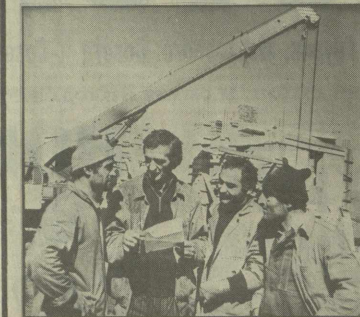
В селе Пена Ахалкалакского района подходит к завершению строительство домов для пострадавших от стихийного бедствия жителей высокогорной Аджары. На строительной площадке и сами пострадавшие. Один из бригадиров Арсен Швадзе, причем в бригаде — только его сыновья и родственники. Освоили они профессии каменщика, плотника, штукатура, работают спорно и качественно — строят-то для себя.
