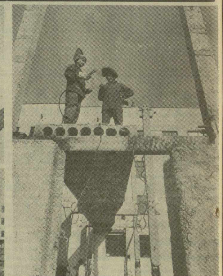
строителям возводить здание; здание строится в Гданском жилом массиве средней школы; на строительстве новой школы.
