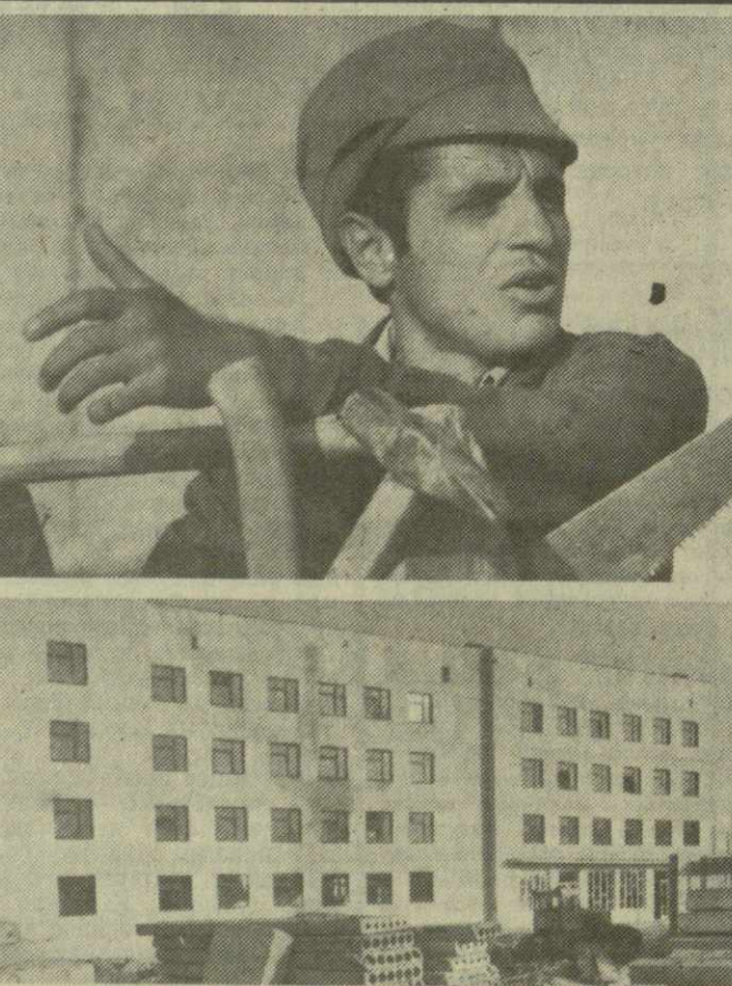
В ялом микрорайоне Гданского жилого массива поднимается кочу строительство нового здания тбилисской средней школы на 1.200 мест. Две комнаты в новой школе отводятся под детскую гостиницу.
