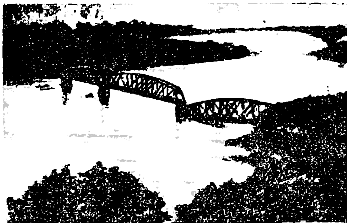
ნახ. 120. ილუს. ძალის ნაშენების ჩამოვარდნა გავივირ. მართულებით. ბიდან. ასეთი მოვლენების უშუალო მიზეზია თარაზული სეისმური ძალები ძალის ნაშენის წინისგან. მათთან ახლავს საკრდენი
