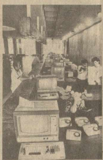
Автоматизированная справочно-информационная служба абонентского отдела Тбилисской межгородской телефонной станции внедрена Республиканским информационно-вычислительным центром Министрства связи Грузинской ССР и ТМТС. Отныне рабочее место каждого оператора оснащено дисплеем и печатными устройствами, подключаемыми к ЭВМ марки ЕС-1036. Оператор набирает с клавиатуры дисплея номер телефона абонента и получает возможность в считанные секунды просмотреть на экране всю информацию о задолженности его за междугородные телефонные разговоры.
