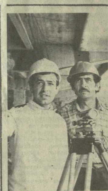
Продвигается строительство морского вокзала в Сухуми. Ведет его мастер-строитель № 9 треста «Новороссийскморстрой». Сейчас завершается монтаж всех этажей здания вокзала.
