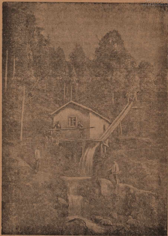
Курорт Саирмэ. Гидростанция.
