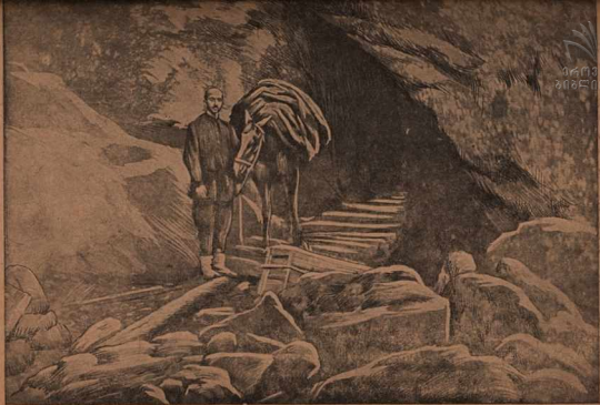
Дорога в Свириз. Проход под каменными глыбами.
