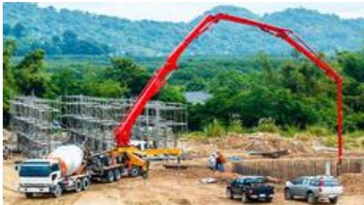
სურ.3.38. ბეტონის მიწოდება დაბალ ნიშნულზე ბეტონსატუმბის მეშვეობით
