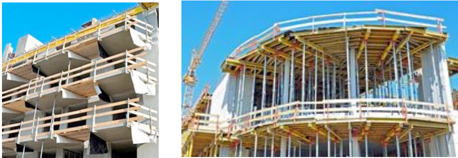
სურ. 8.1. დროებითი დამცავი კონსტრუქციები სიმაღლეზე მუშაობის პირობებში
