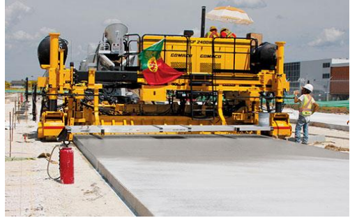
სურ. 3.41. ამერიკული მაგისტრალური ბეტონდამგები Gomaco GP-2400
