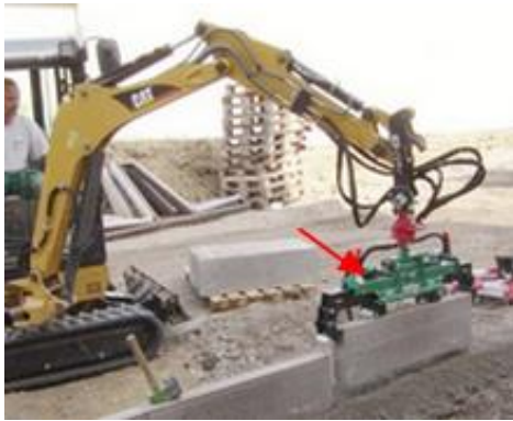
სურ. 3.59. გზების სარემონტო მანქანა EWR150E გერმანული მარწხით Hunklinger S-100
