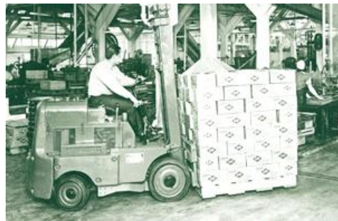
სურ. 6.3. ამერიკული კომპანია „Clark Equipment Co“ მიერ შექმნილი კომფაქტური ავტოსატვირთველი. 1938 წ.
