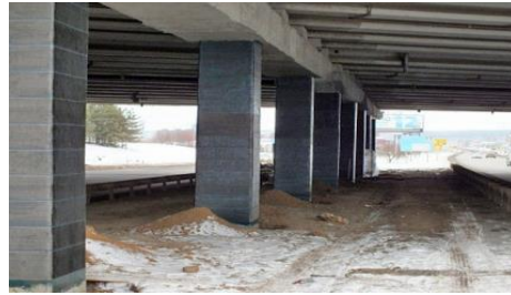
სურ. 11.14. რკინაბეტონის ხიდის შუა საყრდენების გაძლიერება ნახშირბადბოჭკოვანი ლენტიტ FibArm (რუსეთის ფედერაცია)
