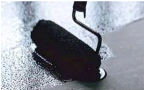
სურ. 8.38. ცხელი მასტიკის ზედაპირზე დატანა საგორავით
