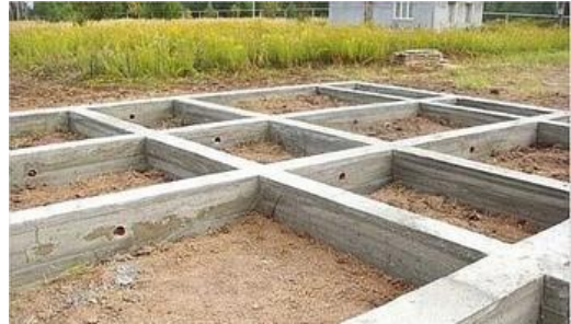
სურ. 9.4. მონოლითური ბეტონის ლენტური საძირკველი
