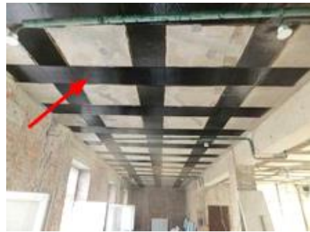
სურ. 11. 6. რკინაბეტონის გადახურვის გაძლიერება ქვედა მხრიდან ნახშირბადბოჭკოვანი ლენტით
