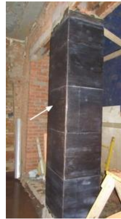
სურ. 11.19. აგურის სვეტის გაძლიერება ნახშირბადბოჭკოვანი კომპოზიტიური გარსაცმით
