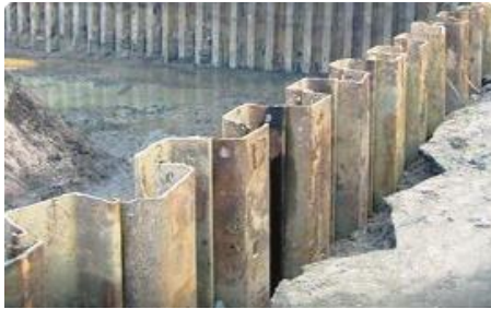
სურ. 8.43. ფილტრაციასაწინაღო ფარდის მოწყობა
