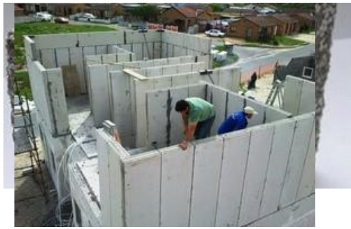
სურ. 9.25. პოლისტირენბეტონის საკედლე პანელები
