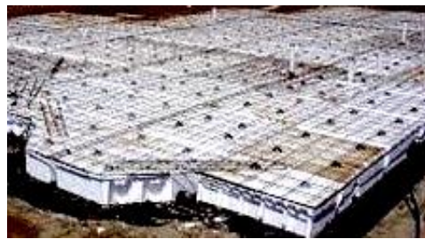
სურ. 9.27. პოლისტირენბეტონის როსტვერკი
