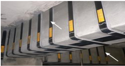
სურ. 11.13. რკინაბეტონის ხიდის მაღის ნაშენის მზიდი კოჭების გაძლიერება ზოლოვანი ნახშირ- ბადფიბროპლასტიკით
