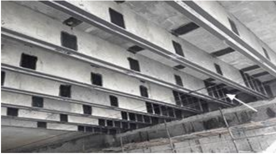
სურ. 11.11. გრძივი მზიდი კოჭების გაძლიერება ნახშირბადბოჭკოვანი ლენტიტ
