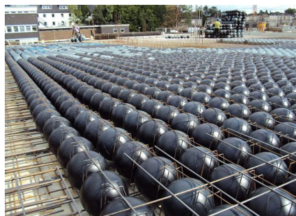
11.30. რკინაბეტონის მონოლითური მოედნის მოწყობა კობიაქსის სისტემის გამოყენებით
