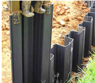
სურ. 8.43. ფილტრაციასაწინაღო ფარდის მოწყობა
