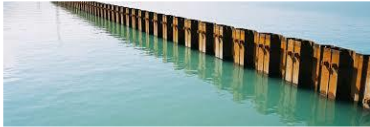
სურ. 8.45. წყალსატევების ნაპირგამაგრება შპუნტებით
