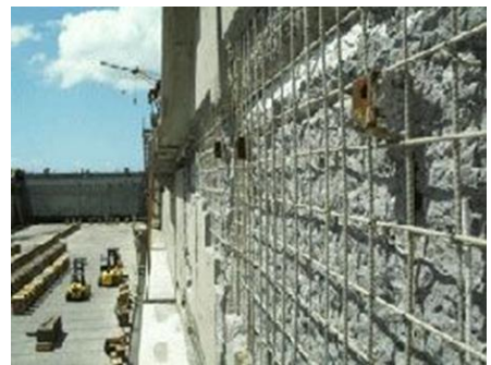
სურ. 10.24. კომპოზიტური არმატურის ბადეები კედლის გასამაგრებლად ნაშხეფბეტონით
