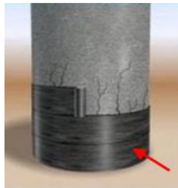
სურ. 12.7. რკინაბეტონის სვეტის გაძლიერება ნახშირბადოჭკვანი კომპოზიტით
