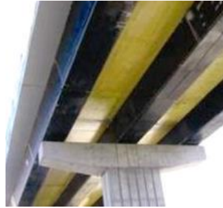
სურ. 11.12. ავტოსაგზაო ხიდის გრძივი წიბოების გაძლიერება ნახშირბად- ბოჭკოვანი ლენტიტ
