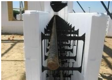
სურ. 9.26. კედლის კონსტრუქცია და ბეტონებამდე
