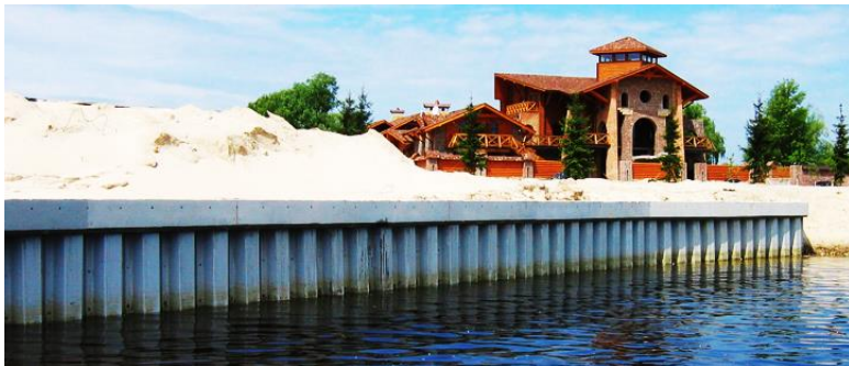
სურ. 8.43. ფილტრაციასაწინაღო ფარდის მოწყობა
