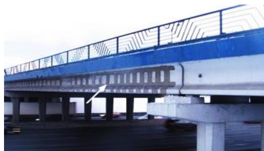
სურ. 11.36. სისტემა კარბონვრაპით გაძლიერებული რკინაბეტონის ხიდის მალის ნაშენი
