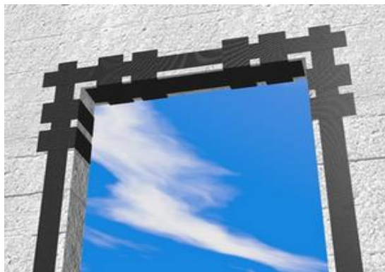
სურ. 11.20. ქვის კედლის ღიობის გაძლიერება ნახშირბადბოჭკოვანი ლენტით
