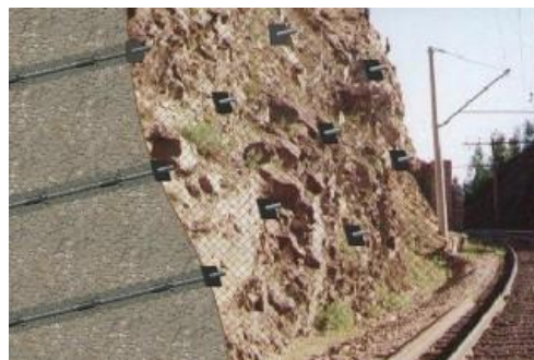
სურ. 10.34. რკინიგზის ფერდოს გამაგრება კომპოზიტური არმატურით
