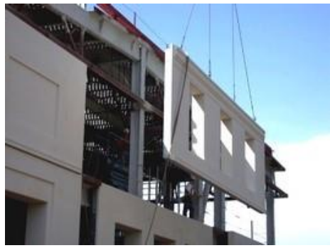
სურ. 9.29. გარე კედლის ასაწყობი პანელი (სამონტაჟე ერთეული)
