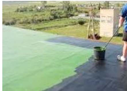
სურ. 8.39. ცივი მასტიკის ზედაპირზე დატანა საგორავით
