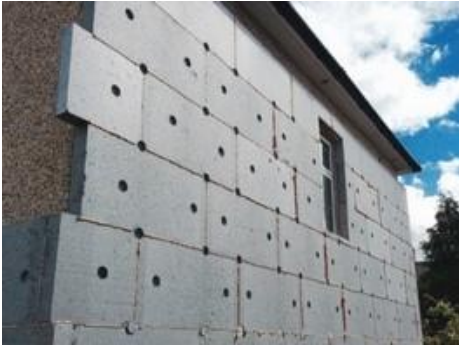
სურ. 9.28. პოლისტირენბეტონის საკედლე ფილები
