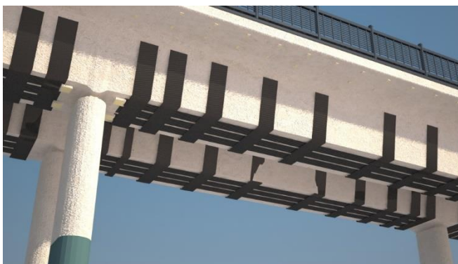
სურ. 11.10. ხიდის მალის ნაშენის გაძლიერება ნახშირბადკომპოზიტური ლენტით
