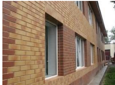
სურ. 9.36. ფასადი მოწყობილი ფიბროცემენტის ფილებით
