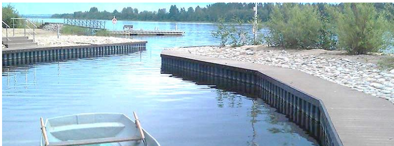
სურ. 8.44. წყალსატევეების ნაპირგამაგრება მპუნტებით
