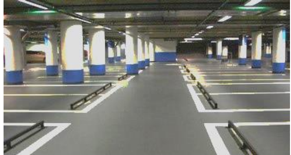
სურ. 9.17. ბეტონპოლიმერის იატაკი პოლიურეთანის საფუძველზე
