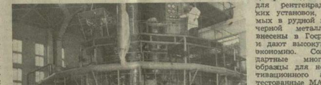
Первый в Закавказье ядерный реактор был сооружен при Институте физики АН Грузии в 1957—1959 гг. и введен на мощность в ноябре 1959 г.
