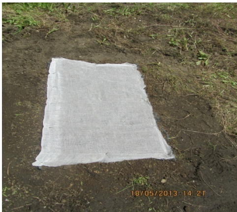
სურ. 1. ფერდობზე დამონტაჟებული გეოხალინა “Coton Mat”
