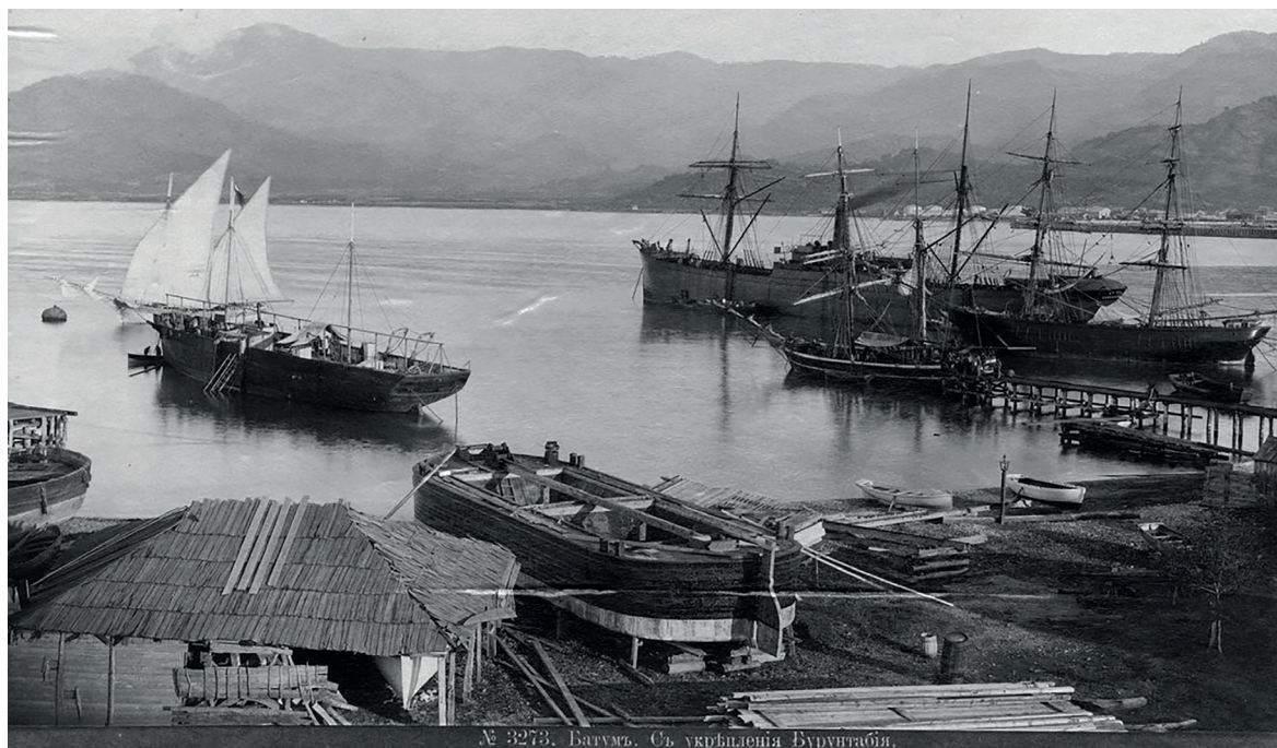
№ 3273. Батумь. Съ укрѣпленія Бурунтаблѣ.
