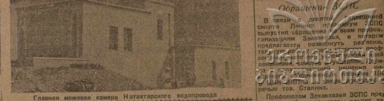
Главная межвал камера Натахтарского водопровода
