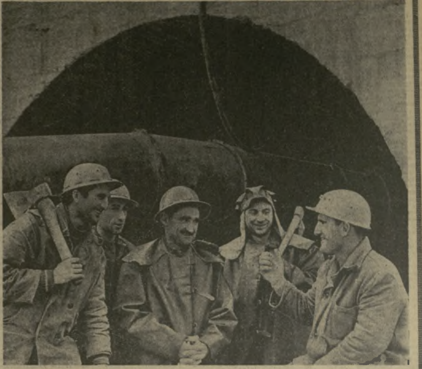
Фотосъемка на объекте строительства ИнгуриГЭС.
