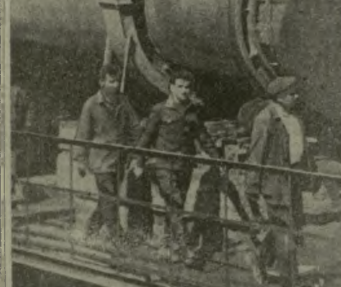
В Каспикском районе в юбилейном году вступило в строй керамическое производство, которое будет выпускать легкий и практичный строительный материал — керамзит. На снимке: цех обжига нового производства. Фото С. Киладзе.
