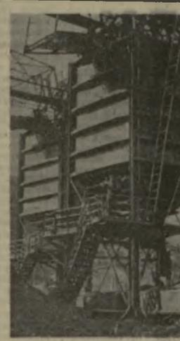
На снимке: Чистура. Новый бункер разгрузочной станции канатной дороги. Апрель, 1938 г.
