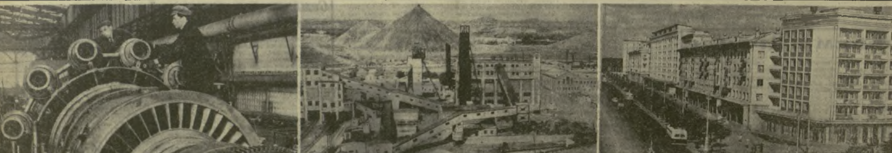
Колыбель Великой Октябрьской социалистической революции Ленинград. Горняцкий завод-трубопрокатный завод и юбилей Советской власти создается уникальная газовая турбина мощностью 108 тысяч киловатт. На снимке: идет монтаж турбины. Фото П. Федотова. Донецк. Крупнейший центр металлургической и угольной промышленности Украины. В его окрестностях расположились крупные и наиболее глубокие угольные шахты. Во все концы страны посылает Донбасс «хлеб промышленности» — уголь. На снимке: шахта коммунистического труда № 5-бис Трудовская. Фото А. Азряеля. Минск. Сердце Советской Белоруссии. Древний и вечно юный город, отразивший на днях свое 900-летие. Минск сегодня — один из красивейших городов страны. Город заводов и фабрик, вузов и научных учреждений, город высокой социалистической культуры. На снимке: Ленинский проспект в Минске. Фото М. Минковича.
