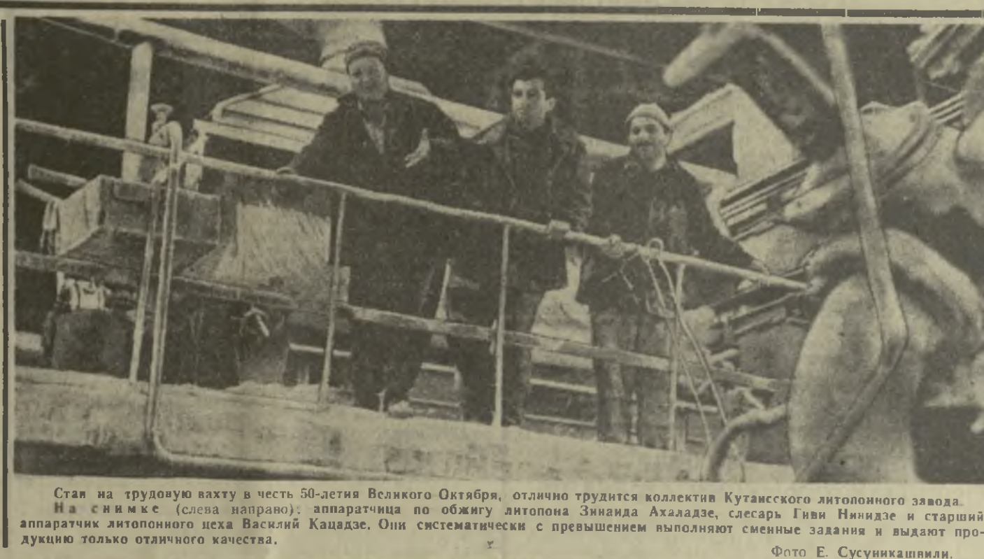
Стан на трудовую вахту в честь 50-летия Великого Октября, отлично трудится коллектив Кутаисского литейного завода. На снимке (слева направо): аппаратчик по обжигу литопона Зинаида Ахаладзе, слесарь Гиви Нииндзе и старший аппаратчик литопонного шихта Василий Кацадзе. Они систематически с превышением выполняют сменные задания и выдают продукцию только отличного качества.
