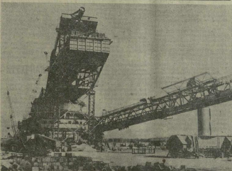
▲ БЕЛХАТУВСКИЙ ТОПЛИВНО-ЭНЕРГЕТИЧЕСКИЙ КОМПЛЕКС — крупнейшая стройка пятилетия в народной Польше. Он будет введен в строй в 1980 году. Этот мощный экскаватор (на снимке) будет работать на открытой добыче бурого угля. Фото ЦАФ — ТАСС.
