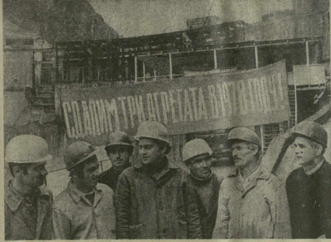
На снимке: передовые строители ИнгуриГЭС (слева направо) электрики Т. Мепаришвили, Ш. Шерозия, В. Кура, слесарь-механик Б. Габедва, монтажники С. Микоза, М. Шамугия и электрик А. Кадария. Фото В. Моргунова. (Фотохроника ГрузИНФОРМА).
