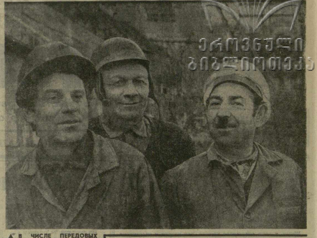
В ЧИСЛЕ ПЕРЕДОВЫХ БРИГАД на строительстве плотин ИнгуриЭС — интернациональная бригада механизаторов, которой руководит И. Маркучи. Эта бригада обязалась на два месяца раньше срока завершить план третьего года десятой пятилетки.
