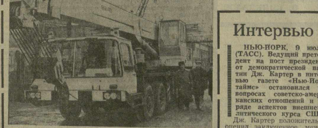
На снимке вверху: новый серийный гидравлический самоходный строительный 40-тонный кран, изготовленный советскими специалистами и рабочими совместно с машиностроителями Польши. (Фотохроника ТАСС).
