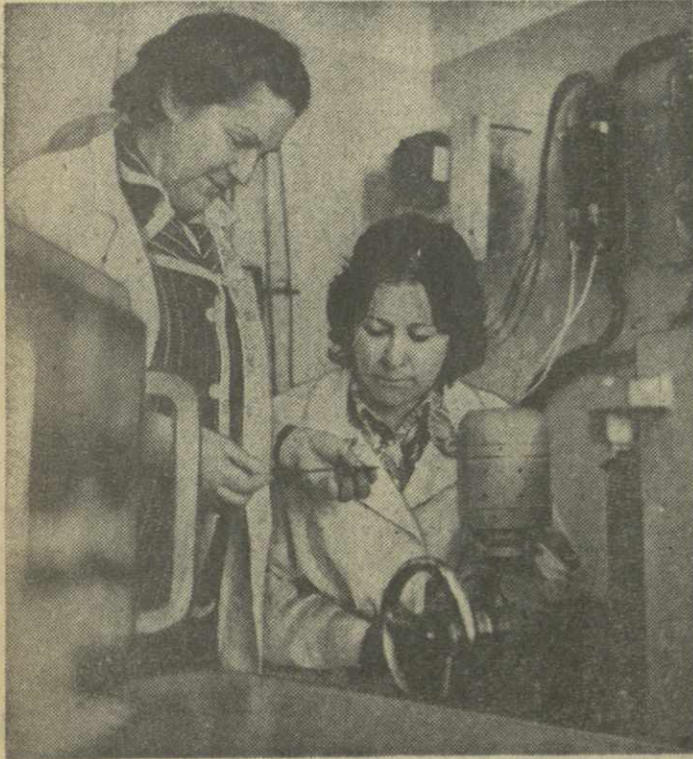
▲ В ЛАБОРАТОРИИ КОРРОЗИИ И ЗАЩИТЫ МЕТАЛЛОВ Института металлургии Академии наук Грузии проводится исследование коррозионной стойкости новых сталей, сплавов и защитных металлических покрытий.
