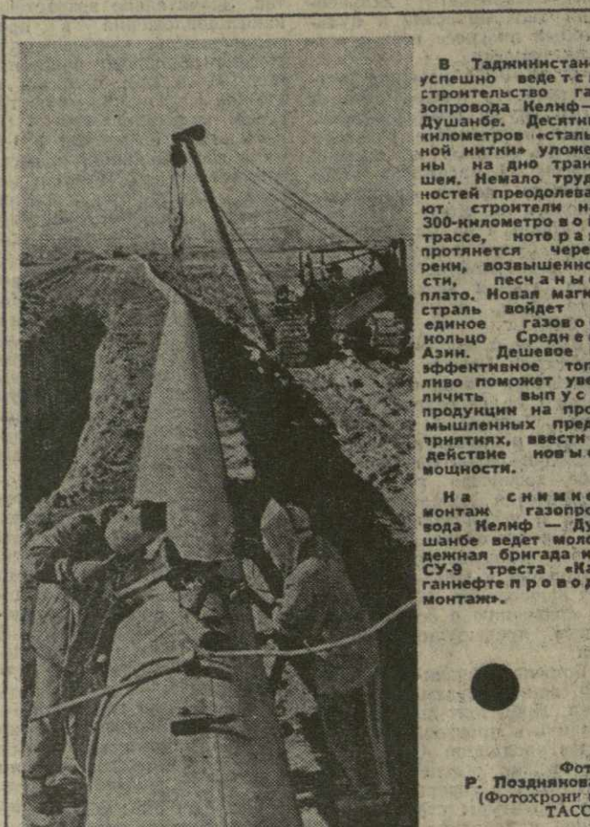
В Таджикистане успешно ведется строительство газотурбинного завода Кельф — Душанбе. Десятки километров «стальной нити» уложены на дно траншеи. Немало трудностей преодолевает строители на 300-метровом в о р трассе, которую в и протыкают через реку, возвышенности, песчаные плато. Но на митинге в пеще в одно из газопроводов в ольце Средней Азии. Дешевое и эффективное топливо поможет увеличить выпуск и промышленной продукции в Таджикистане.
