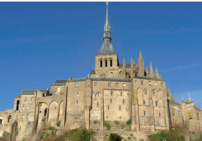
სააბატოს ჩრდილოეთი კედელი მთლიანად გამაგრდა კონტრფორსებით, რამაც იმდენად ძლიერი მხატვრული ეფექტი შექმნა, რომ ვიქტორ ჰიუგომ „ვეროაის ყველაზე ლამაზი კედელი“ უწოდა.
