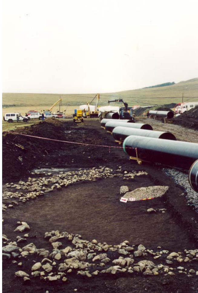
სურ. 27. სამშენებლო სამუშაოები 120-ე კმ-ზე.
