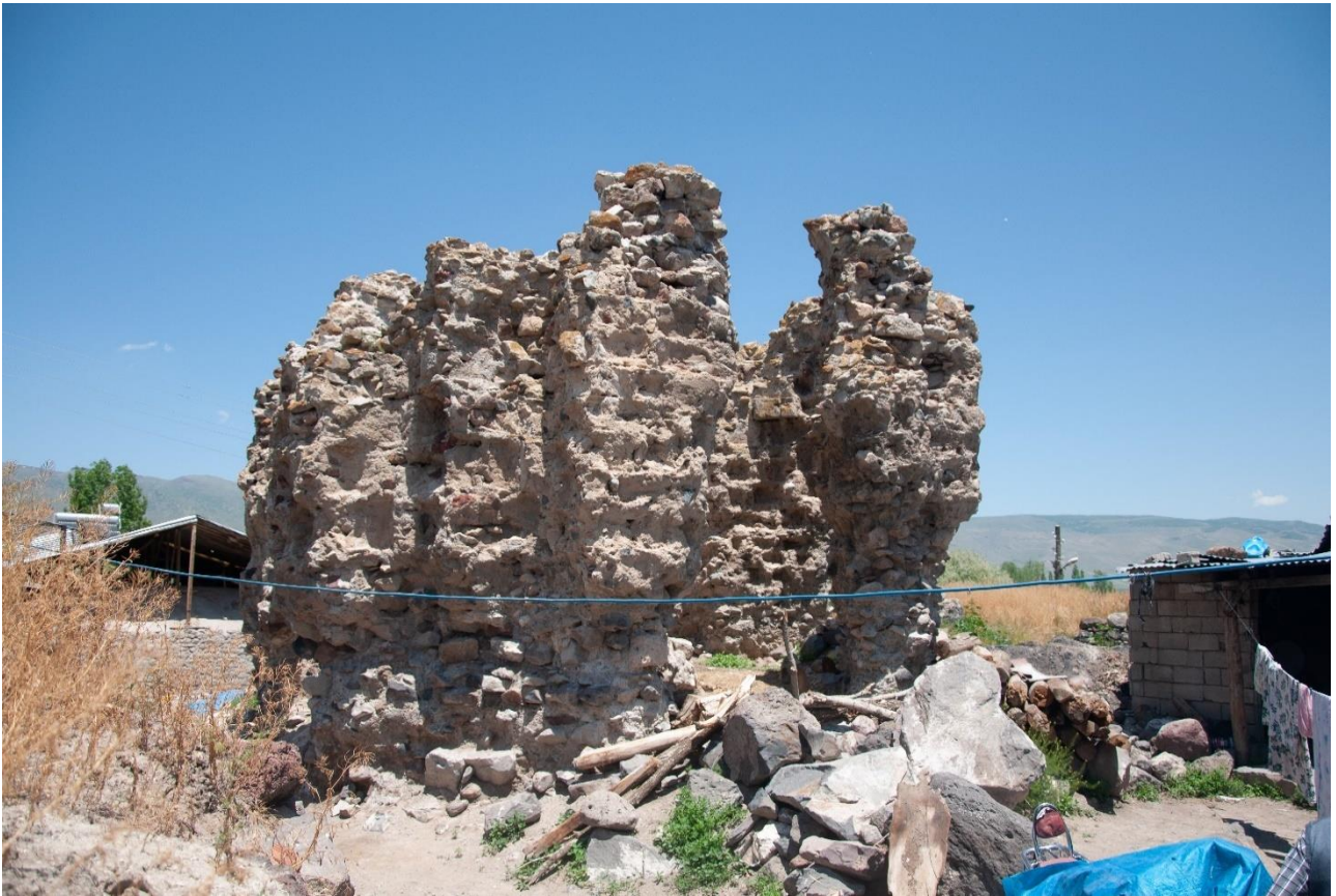
ფოტო/Photo 1. ეკლესიის საერთო ხედი / Church, general view
