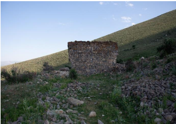
ფოტო/Photo 3. ეკლესიის ხედი ჩრდილოეთიდან / Church, view from the north
