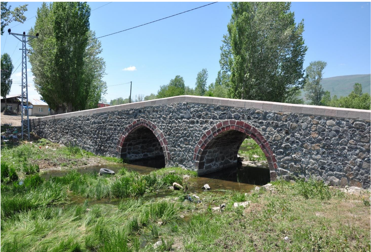
ფოტო/Photo 1. ხიდის საერთო ხედი / Bridge, general view
