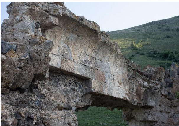
ფოტო/Photo 5. ეკლესიის ინტერ. კამარის სამხრ. ფრაგმ. / Church interior. South fragment of the barrel vault
