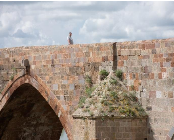
ფოტო/Photo 3. ხიდის კონტრფორსის ფრაგმენტი / Bridge, fragment of a buttress
