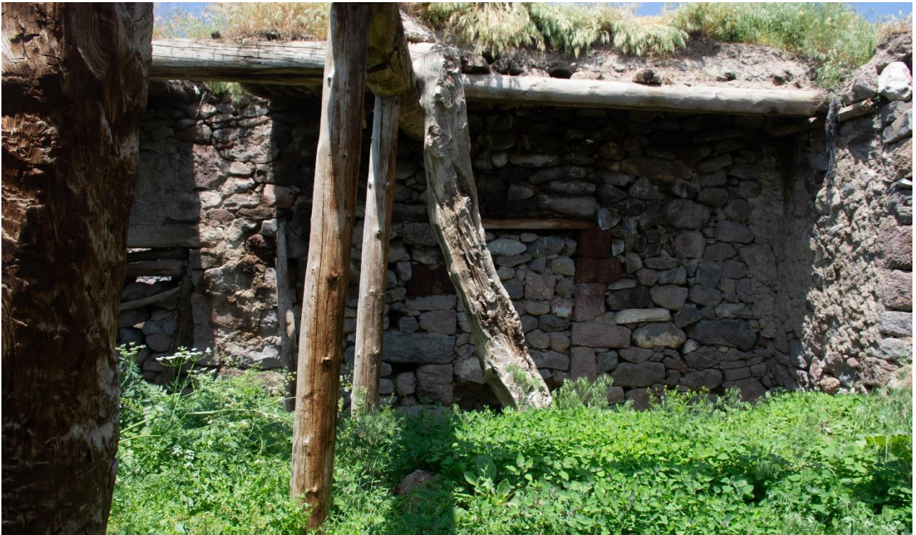
ფოტო/Photo 2. ნაგებობის ინტერიერი / Interior of the building
