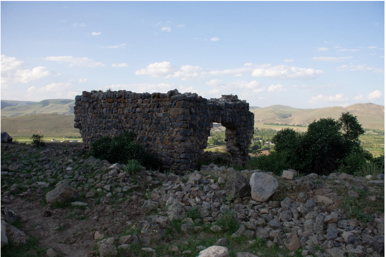
ფოტო/Photo 2. ეკლესიის საერთო ხედი / Church, general view
