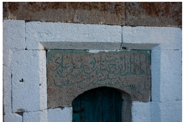
ფოტო/Photo 2. თურბეს კარის არქიტრავე არაბული წარწერებით / Türbe, a door architrave with the inscriptions in Arabic
