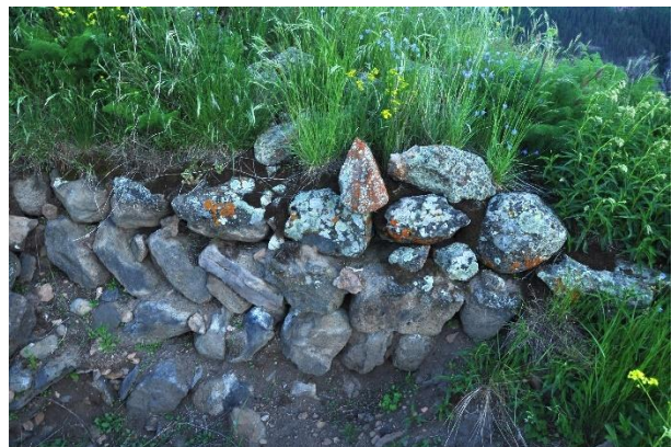
ფოტო/Photo 4. ციხის ინტერიერი, კედლის წყობა / Interior of the fortress, stone masonry
