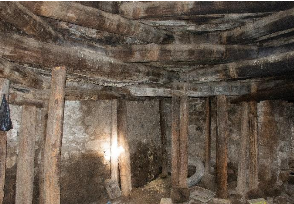
ფოტო/Photo 4, 5. ნაგებობის ინტერიერი, ვივრგვინი / Interior of the building, a pyramidal vault
