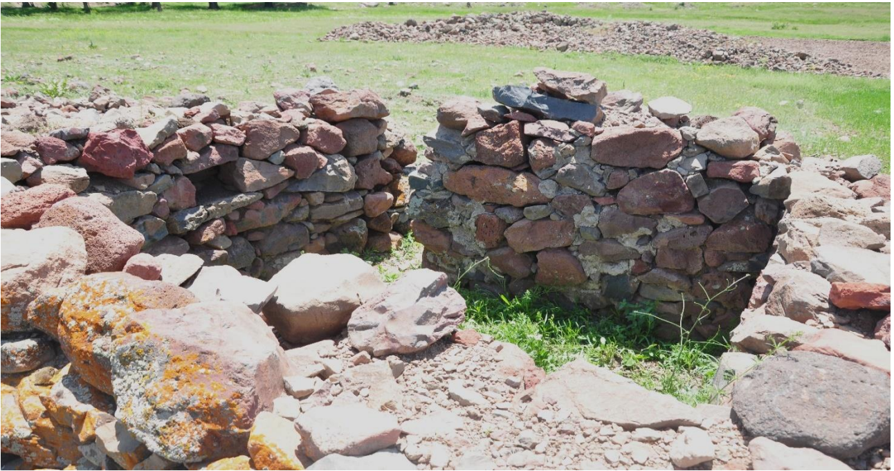
ფოტო/Photo 2. ნაგებობის ფრაგმენტები / Fragments of the building
