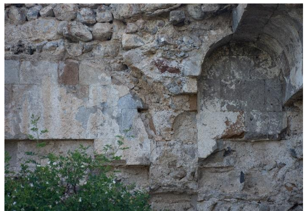
ფოტო/Photo 6. ეკლესიის ინტერ. კამარის ჩრდ. ფრაგმ. / Church interior. North fragment of the barrel vault
