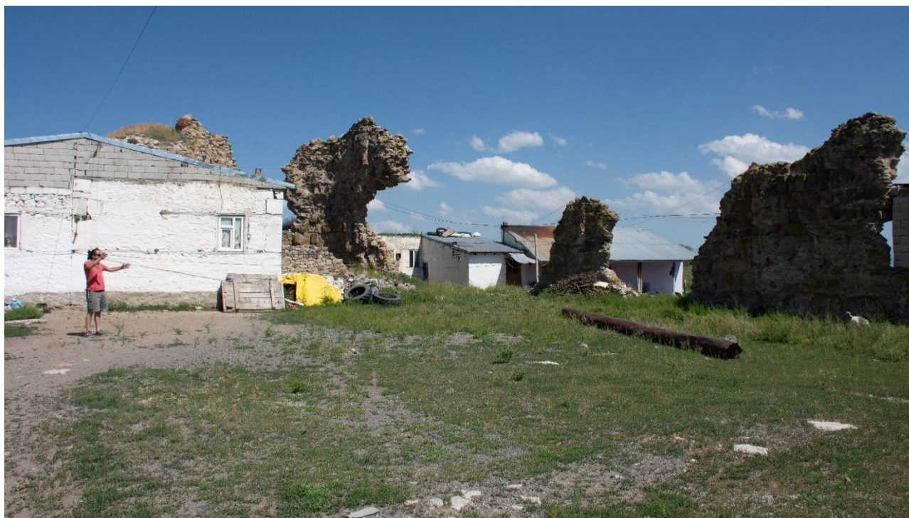
ფოტო/Photo 1. ეკლესიის საერთო ხედი / Church, general view
