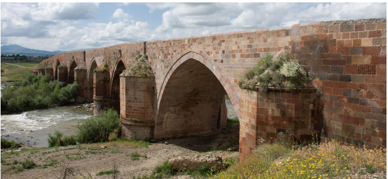
ფოტო/Photo 1. ხიდის საერთო ხედი / Bridge, general view
