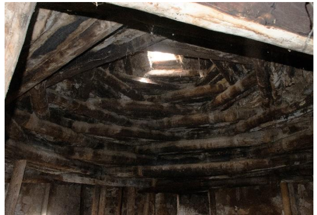
ფოტო/Photo 4, 5. ნაგებობის ინტერიერი, ვივრგვინი / Interior of the building, a pyramidal vault
