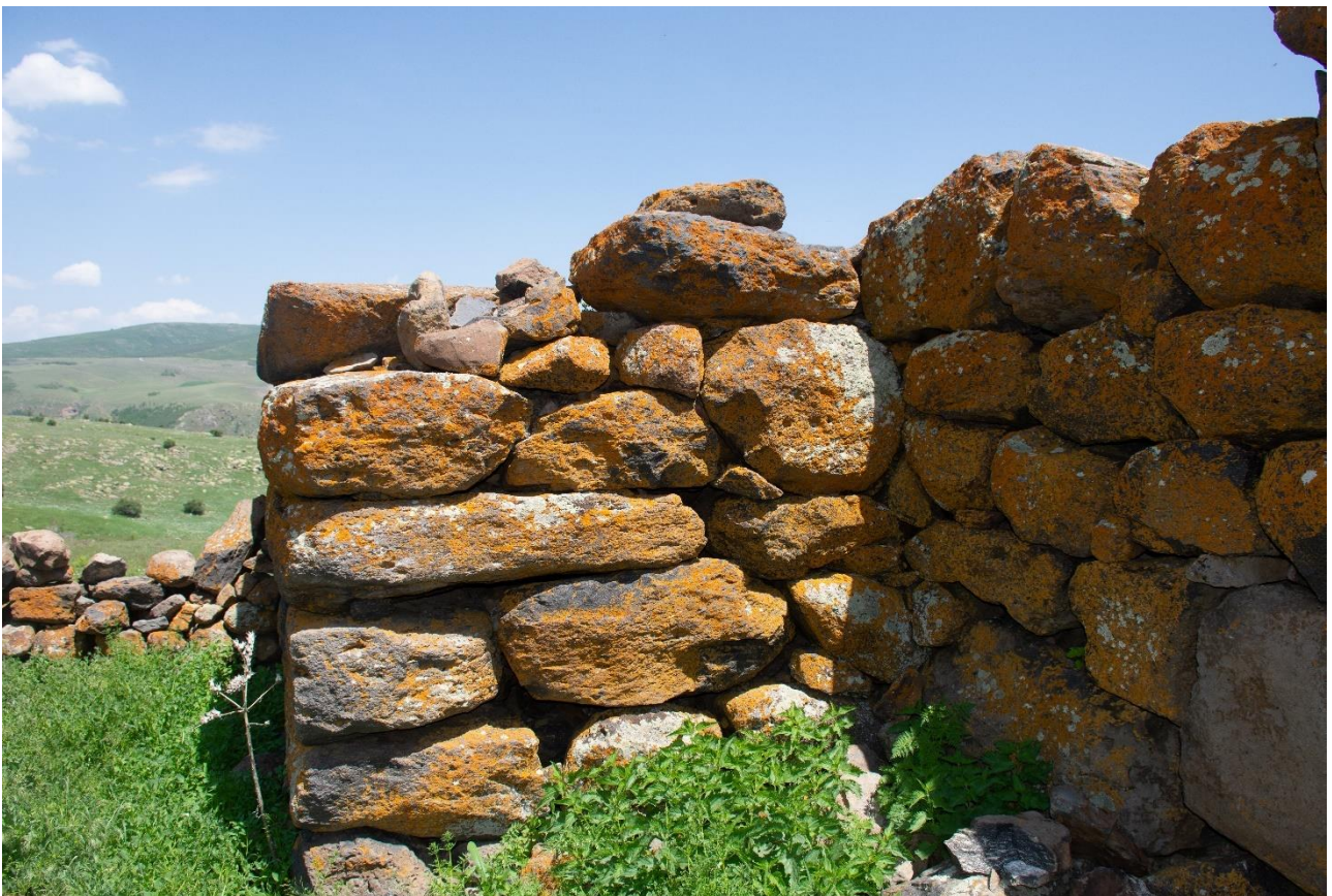
ფოტო/Photo 4. ციხის ჩრდილოეთ კედლის ბურჯი / Buttress on the north wall of the fortress
