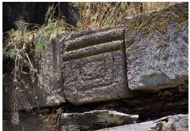
ფოტო/Photo 4. ნაგებობის სამხრ. კედელი, დეკორირებული კარნიზი / South wall of the building; ornamental cornice
