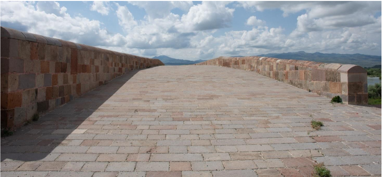
ფოტო/Photo 2. ხიდის სავალი ნაწილი / Bridge, roadway
