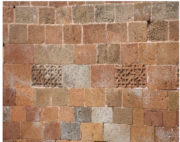
ფოტო/Photo 4. წყობაში ჩართული ორნამენტული ქვები / Ornamental stones within masonry
