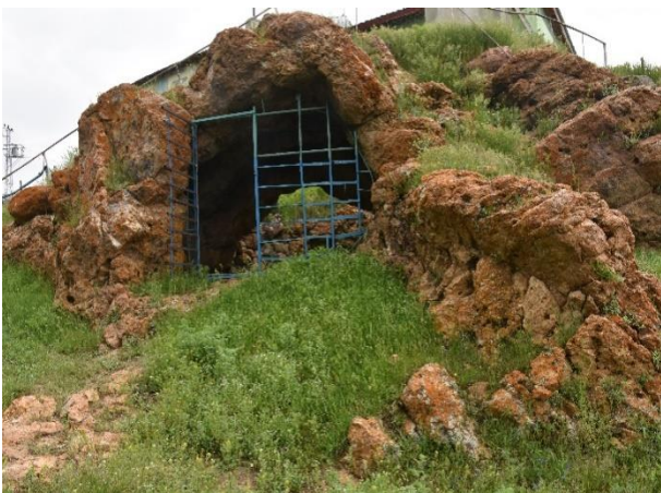
ფოტო/Photo 1. ნაგებობის ფრაგმენტები / Fragments of the building
