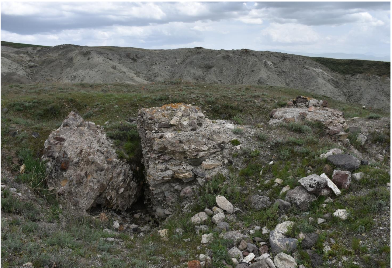
ფოტო/Photo 2. ჩამოქცეული გუმბათი / The collapsed dome
