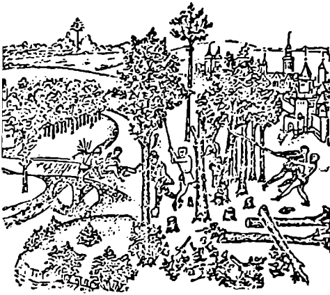
საგზაო სამუშაოები, ხიდის შეკეთება. XV ს-ის მინიატურიდან. ქვის ხიდის მშენებლობა. XV ს-ის მინია- ტურიდან.
