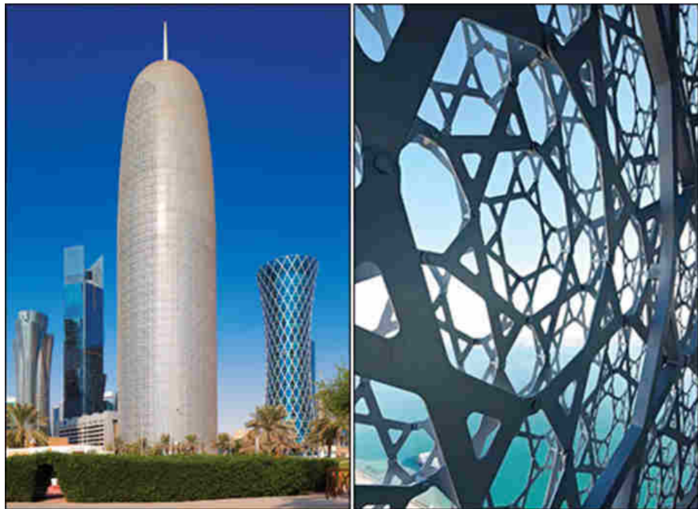
სურ. 4 კომბინირებული მზისგანდამცავი მოწყობილობები
