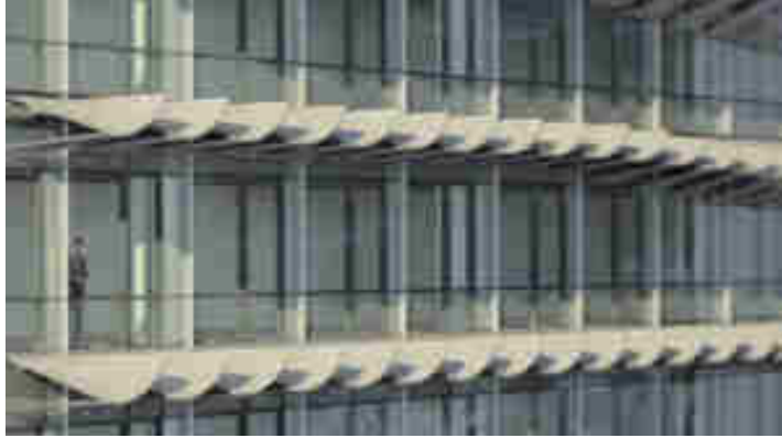
სურ. 5 „ჭკვიანი“ ავტომატიზირებული მზისგანდამცავი ეკრანები
