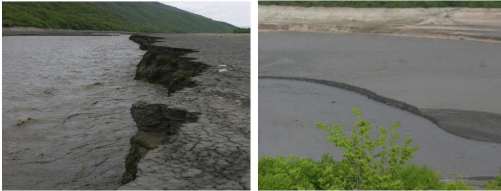
სურ. 1. მთის წყალსაცავების მოსილვის პრიზმის ფრაგმენტები (სეზონური რეგულირების ჟინვალის წყალსაცავი; მოქმედების 45-ე წელი)
