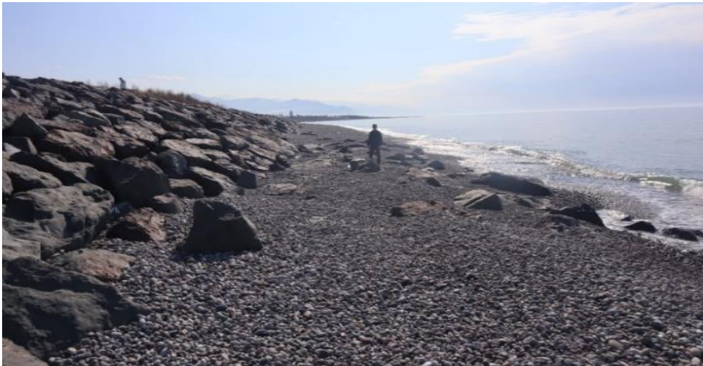
სურ. 9. 2010 წელს დაგებული ლოდნაფენი ადლია-ბათუმის სანაპირო უბნის მონაკვეთზე
