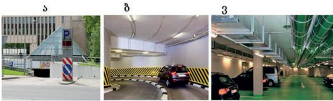
ნახ. 1. მიწისქვეშა ავტოსადგომის ფრაგმენტები [2]: ა) პორტალი; ბ) გვირაბის რამპა; ვ) ავტოსადგომის იარუსი
