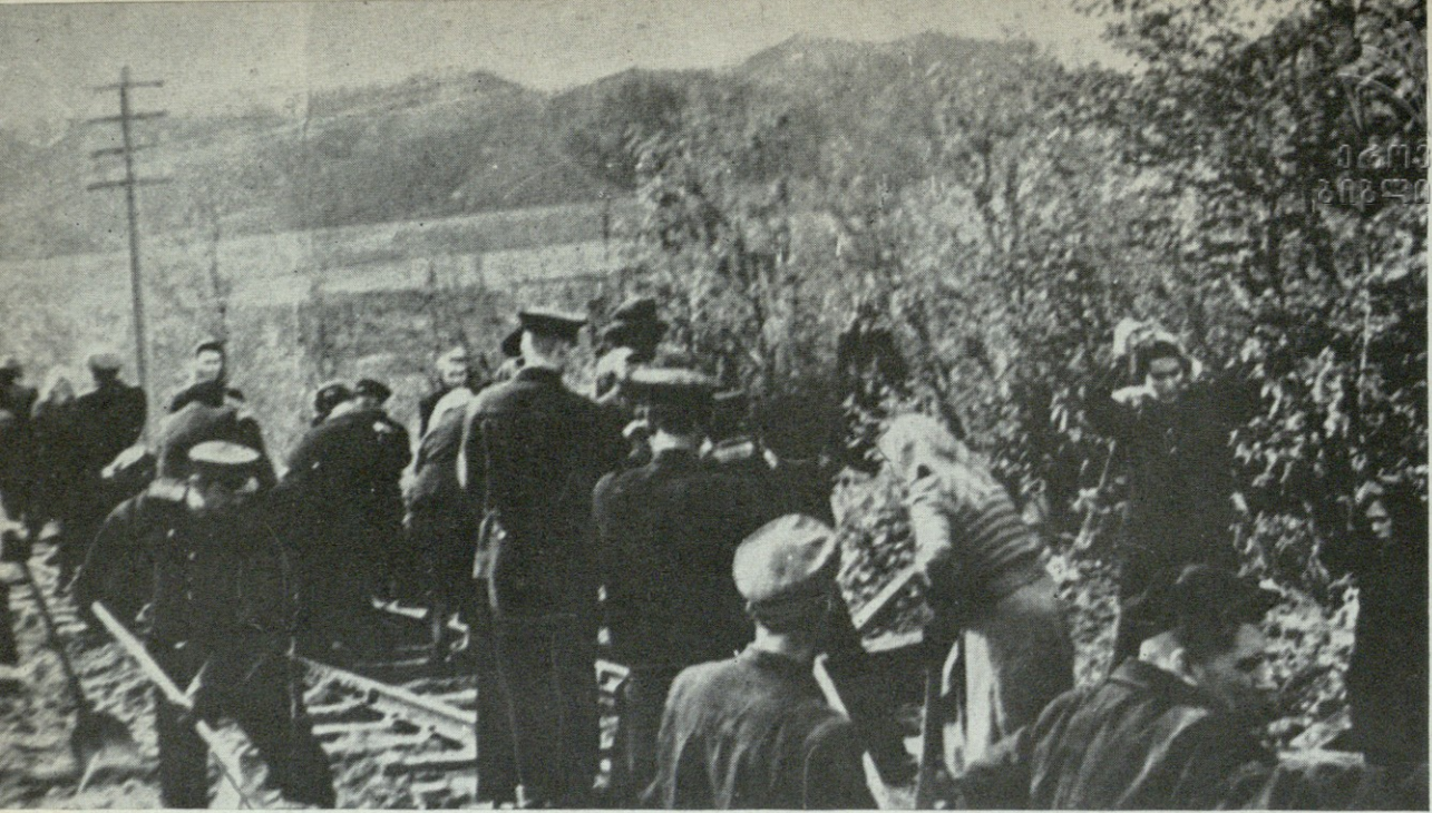
ბამის სახელოვანი ისტორია 30-იანი წლებიდან იწყება. საკვანძო სადგური ნიკოლსკ-უსურისკის მისადგომებთან. მეორადი ლიანდაგის დაგება. Славная история БАМ-а начинается с 30-х годов. Узловая станция в предместье Никольск-Уссурийска Прокладка параллельных линий,
