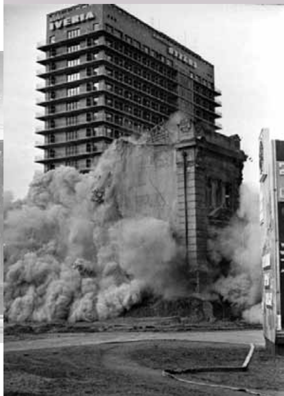
Снос старого здания Центрального телеграфа
