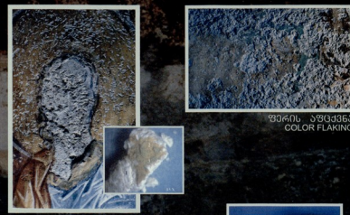
ბატიანის ფაქალი DETACHMENT OF THE PLASTER
