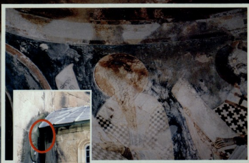
გველის ჩაქვივისგან გამრეცხველი ლაქები STAINS CAUSED BY THE LEAKED WATER
