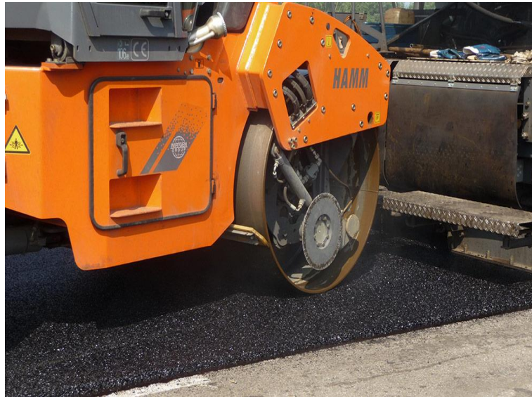
ნახ.18. ნოვაჩიპით საფარის მოწყობა ეკატერინბურგი-რეჟი-ალაპაევსკის გზაზე
