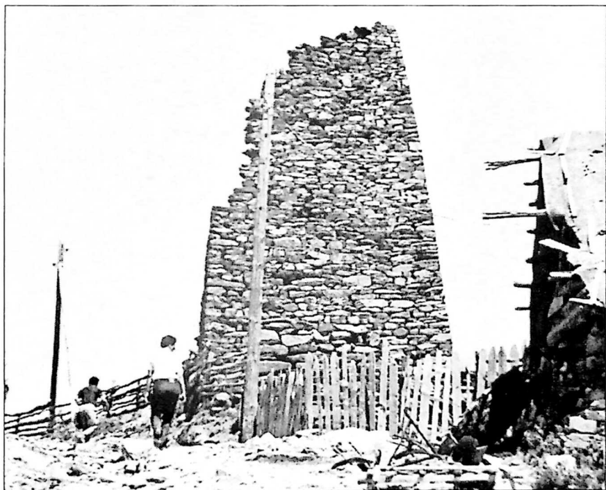
აღმოსავლეთი ფასადი. Восточный фасад
