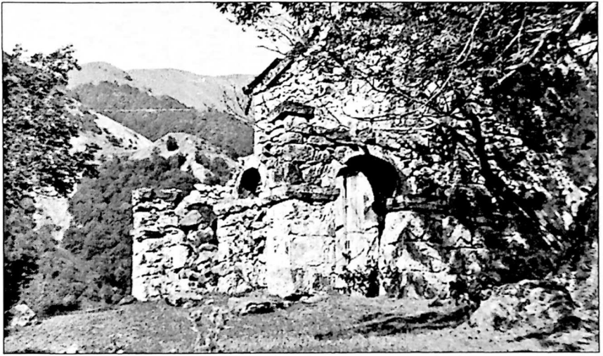
სამხრეთ-დასავლეთი ფასადის ფრაგმენტი. Фрагмент юго-западного фасада
