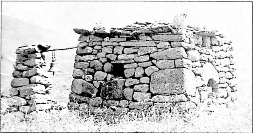
ხედი ჩრდილო-დასავლეთიდან. Вид с северо-запада
