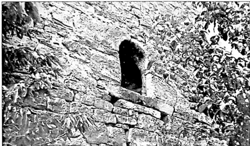
აღმოსავლეთ ფასადის ფრაგმენტი. Фрагмент восточного фасада
