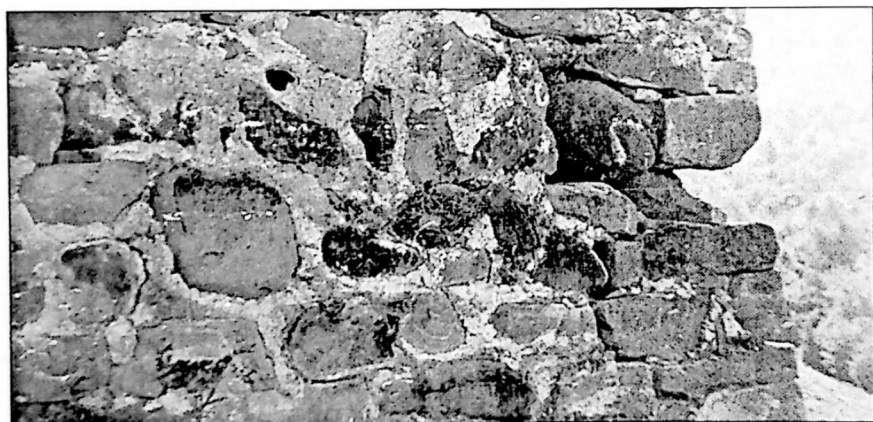
კოშკი. კედლის ფრაგმენტი. Фрагмент стены
