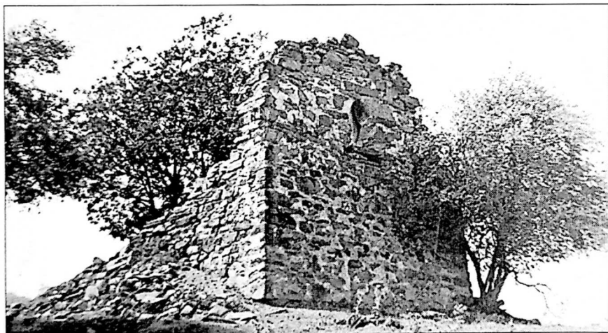
საერთო ხედი სამხრეთ-აღმოსავლეთიდან. Вид с юго-востока
