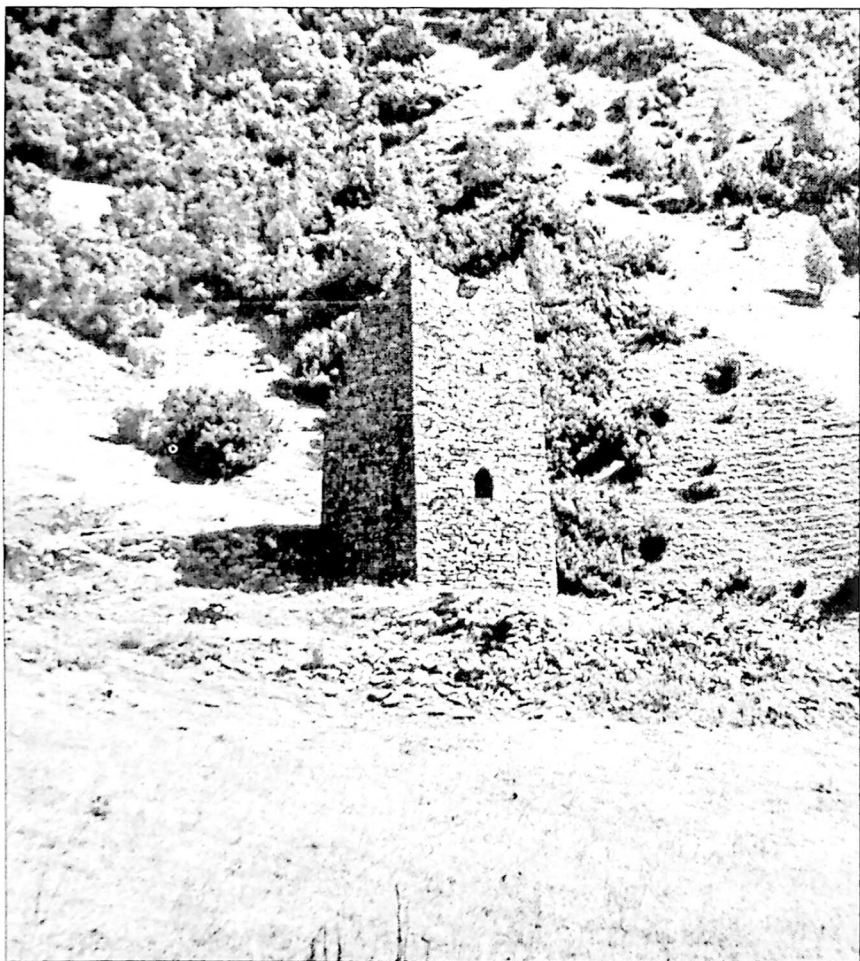
ხედი ჩრდილო-დასავლეთიდან. Вид с северо-запада
