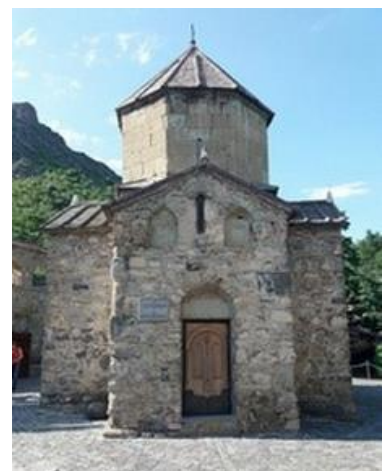
სურ. 3.29.1. საერთო ხედი
