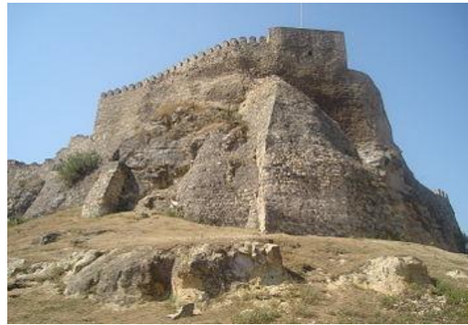
სურ. 3.80.2. საერთო ხედი
