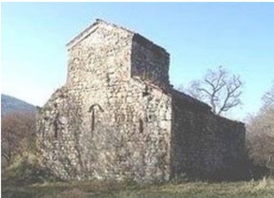
სურ. 3.51.1.1. საერთო ხედი
