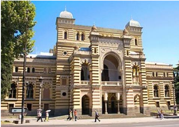
სურ. 4.5.1. საერთო ხედი
