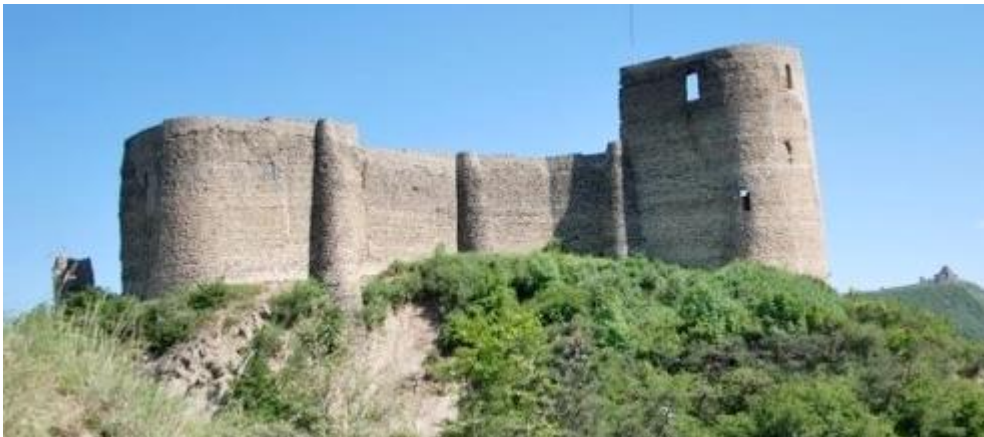
სურ. 3.97.1. საერთო ხედი
