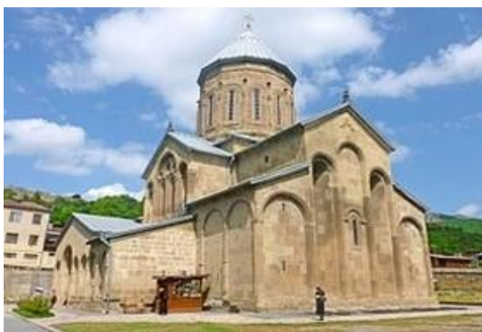
სურ. 3.76.2. საერთო ხედი
