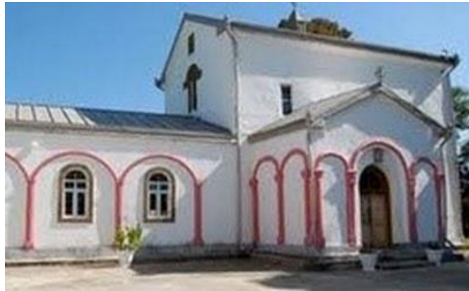
სურ. 3.85.1. საერთო ხედი
