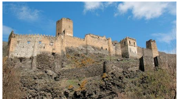
სურ. 3.94.2. საერთო ხედი
