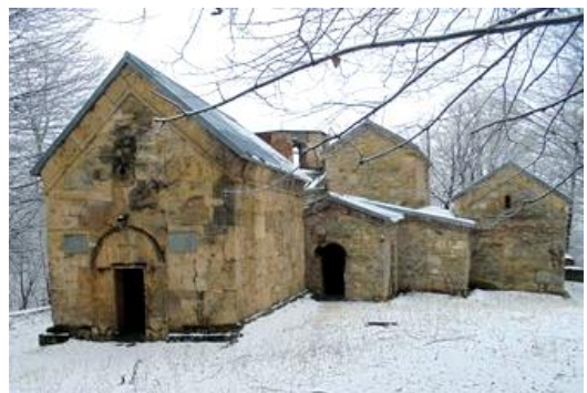
სურ. 3.15.2. საერთო ხედი
