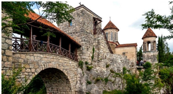
სურ. 3.78.2. საერთო ხედი
