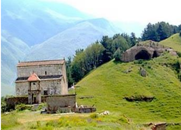
სურ. 3.62.1. საერთო ხედი
