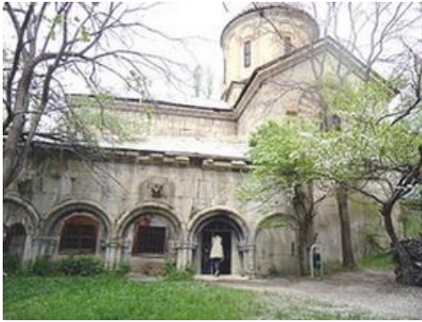
სურ. 3.60.1. საერთო ხედი
