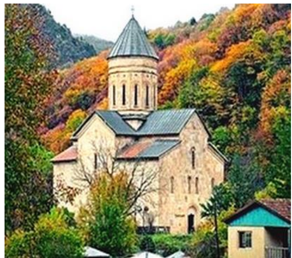
სურ. 3.143.1. საერთო ხედი
