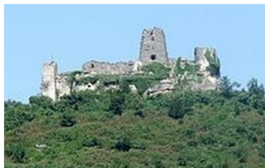
სურ.3.9.2. საერთო ხედი
