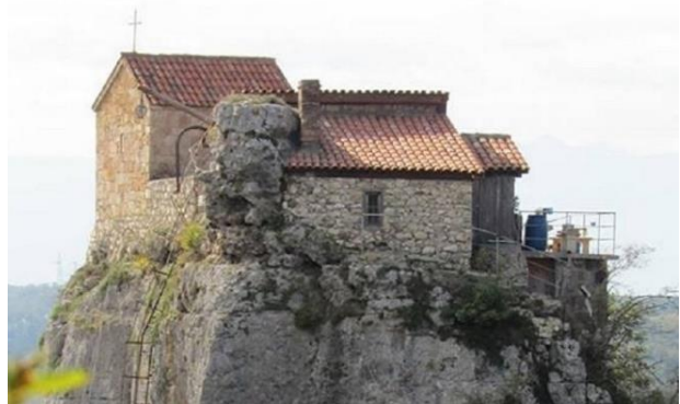
სურ. 3.115.2. საერთო ხედი
