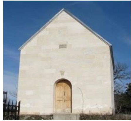
სურ. 3.27.1.1. საერთო ხედი
