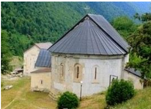
სურ. 3.104.1. საერთო ხედი
