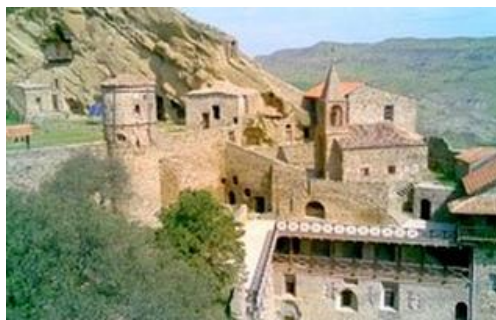
სურ. 3.20.1. საერთო ხედი
