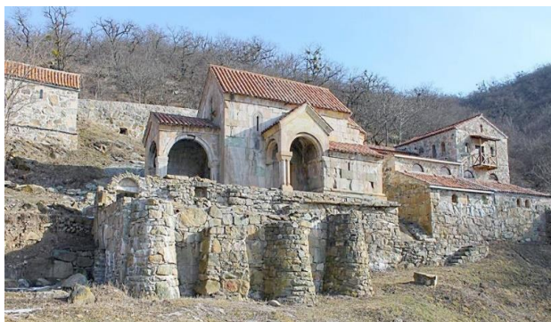
სურ. 3.105.1. საერთო ხედი
