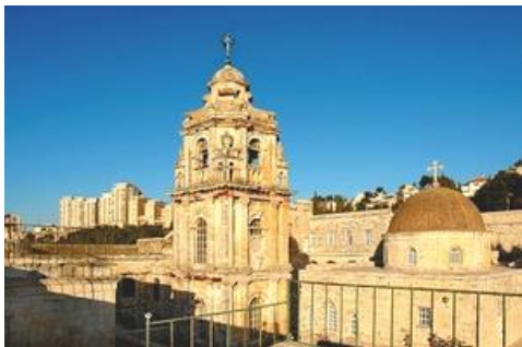
სურ. 3.79.1. საერთო ხედი
