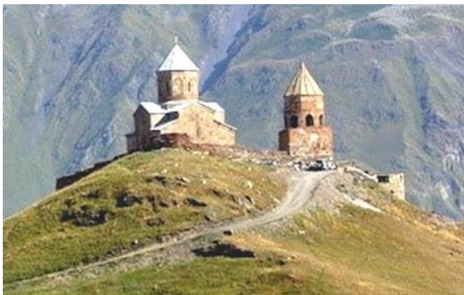
სურ. 3.131.2. საერთო ხედი
