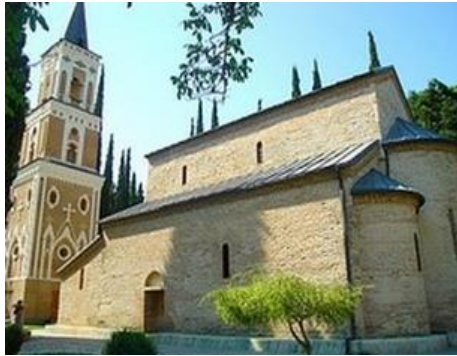
სურ. 3.7.1. საერთო ხედი
