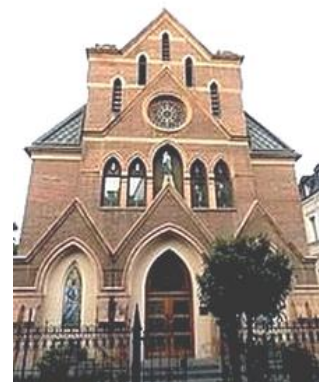
სურ. 3.147.1. საერთო ხედი
