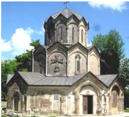
სურ. 3.86.1. საერთო ხედი
