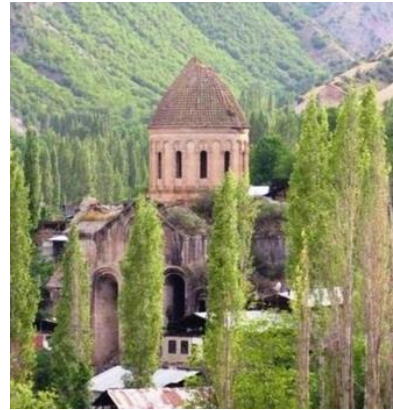
სურ. 3.56.2. საერთო ხედი
