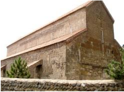
სურ. 3.37.1. საერთო ხედი
