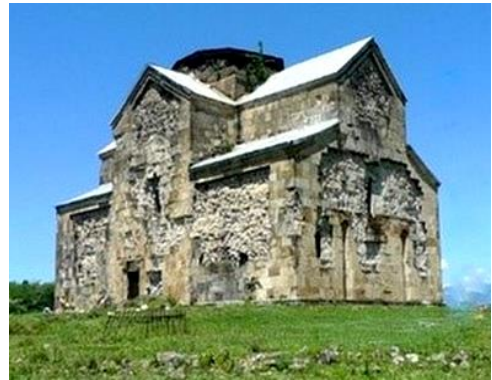
სურ. 3.55.1. საერთო ხედი
