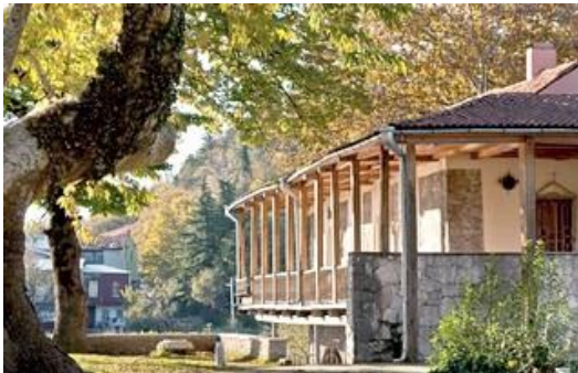
სურ. 4.4.2. საერთო ხედი
