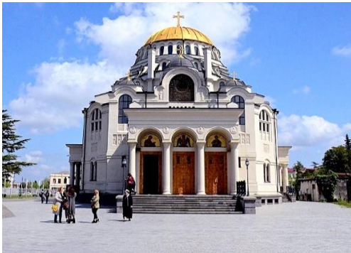
სურ. 3.156.2. საერთო ხედი
