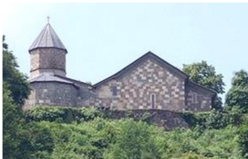
სურ. 3.130.1. საერთო ხედი
