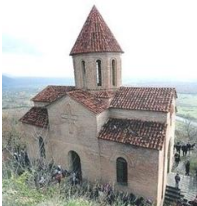
სურ. 3.120.1. საერთო ხედი
