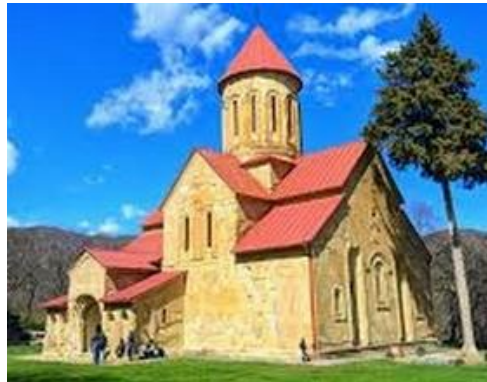
სურ. 3.95.2. საერთო ხედი
