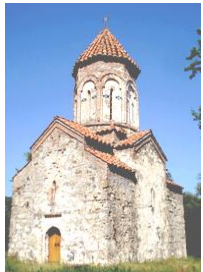
სურ. 3.136.1. საერთო ხედი
