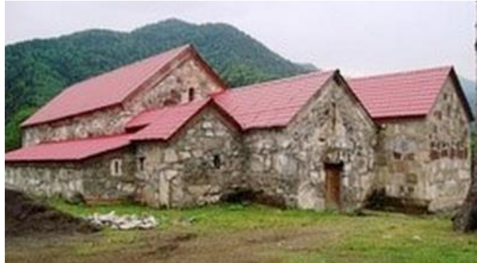
სურ. 3.33.1. საერთო ხედი
