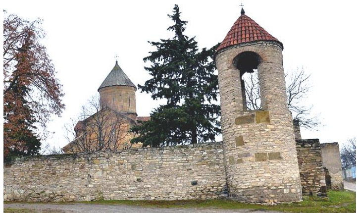
სურ. 3.123.1. საერთო ხედი
