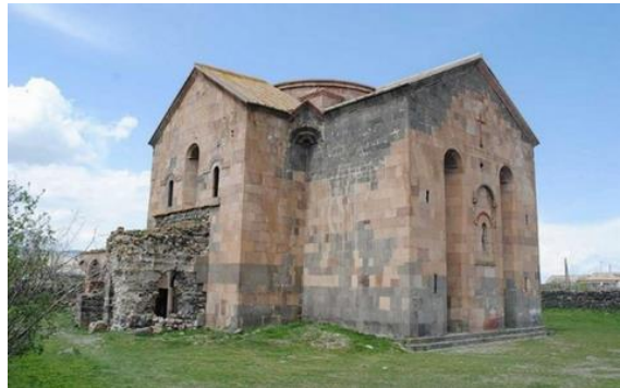
სურ. 3.61.1. საერთო ხედი
