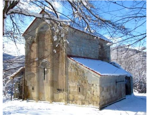
სურ. 3.107.1. საერთო ხედი
