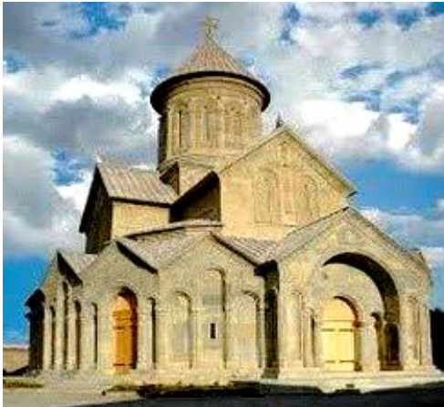
სურ. 3.160.1. საერთო ხედი
