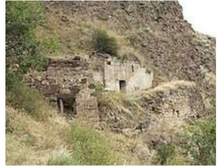
სურ. 3.122.1. საერთო ხედი
