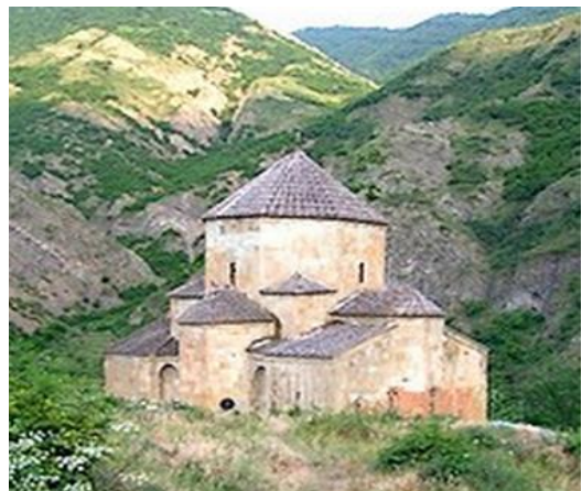
სურ. 3.28.1. საერთო ხედი
