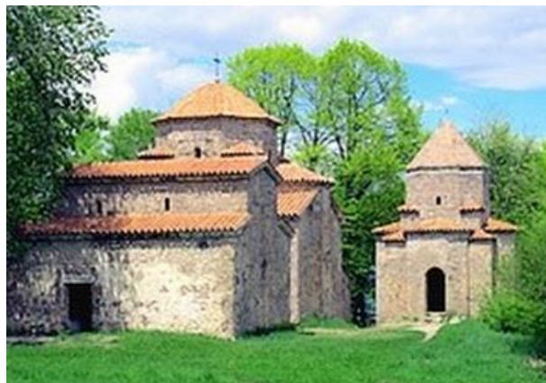
სურ. 3.38.1. საერთო ხედი
