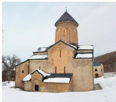
სურ. 3.99.2. საერთო ხედი
