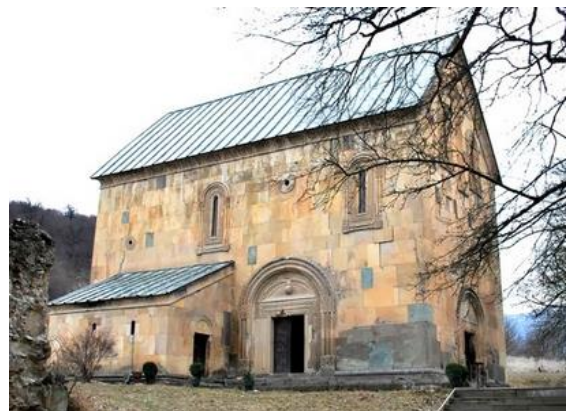
სურ. 3.113.1. საერთო ხედი
