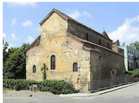
სურ. 3.19.2. საერთო ხედი
