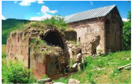
სურ. 3.63.1. საერთო ხედი
