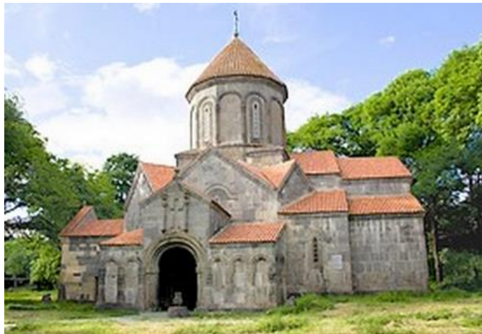
სურ. 3.88.1. საერთო ხედი
