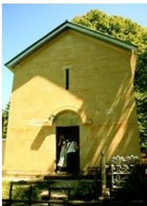
სურ. 3.89.1. საერთო ხედი
