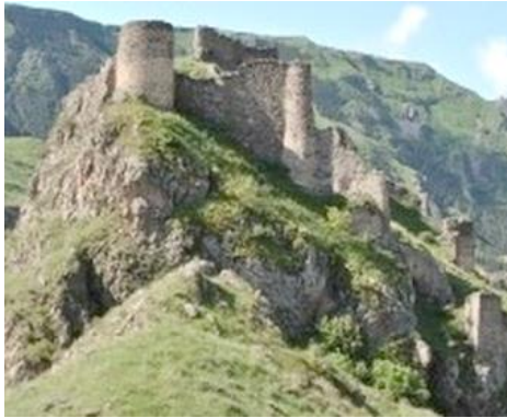
სურ. 3.52.1. საერთო ხედი
