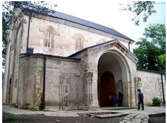
სურ. 3.108.1. საერთო ხედი
