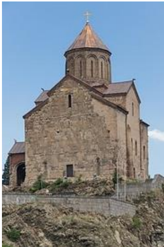
სურ. 3.14.3. საერთო ხედი
