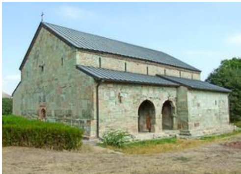
სურ. 3.13.1. საერთო ხედი
