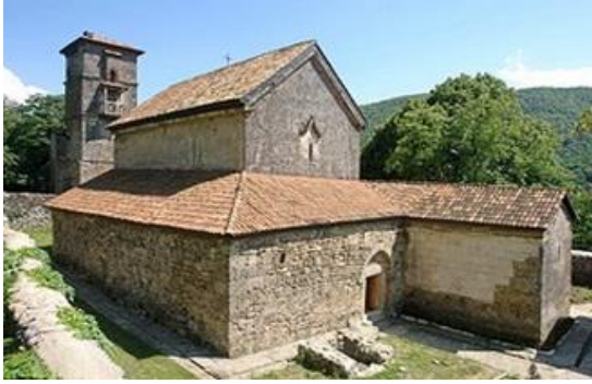
სურ. 3.47.1. საერთო ხედი
