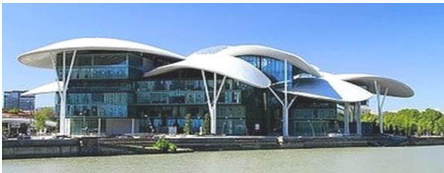
სურ. 4.13.1. საერთო ხედი
