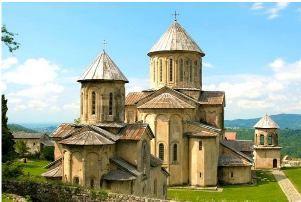
სურ. 3.93.1. საერთო ხედი
