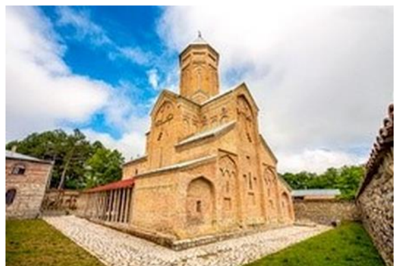
სურ. 3.135.1. საერთო ხედი
