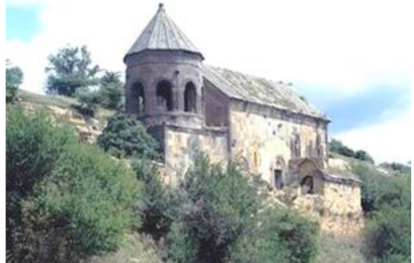
სურ. 3.125.1. საერთო ხედი
