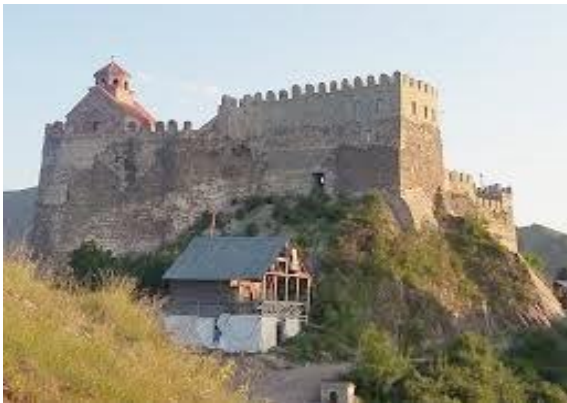
სურ. 3.70.1. საერთო ხედი
