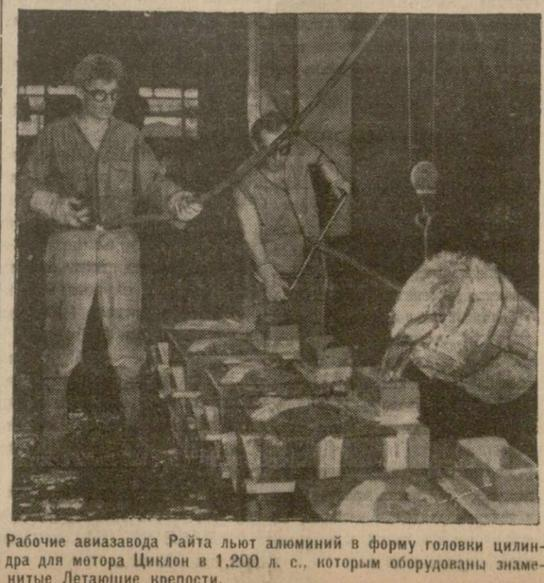
Рабочие авиазавода Райта лют алюминий в форму головки цилиндра для мотора Диклон в 1.200 л. с., которым оборудованы знаменитые Летящие крепости.
