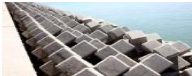
ფოტო VIII.3.3. აბრაზიული ნაპირის გამაგრება სპეციალური კონსტრუქციების მრავალრიგიანი წყობით (აშშ)
