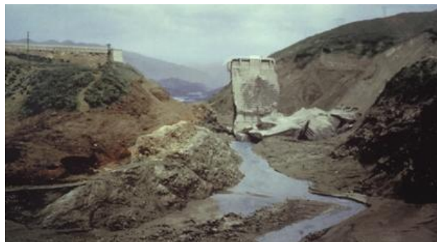
ნახ. XI.1.2. სენტ-ფრენსისის ბეტონის კაშხლის კატასტროფა, 1928 წ. (აშშ, კალიფორნია) ა. დანგრეული კაშხლის პროფილი; ბ. კაშხლის ხედი კატასტროფამდე; გ. ბეტონის კაშხლის ცენტრალურ ნაწილში დარჩენილი ვიწრო სეგმენტის ფოტო
