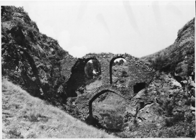
აკვადუკი მშრალ ხევზე
