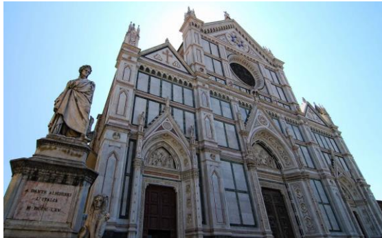
სანტა კროჩეს ბაზილიკა არქიტექტორი არნოლფო დი კამბიო, 1294-1385, ფლორენცია
