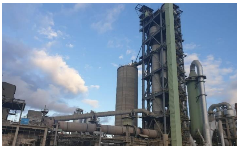
სურათი 1. კასპის ცემენტის ქარხანა, დეკარბონიზატორიანი ღუმელი, 2018 წელი
